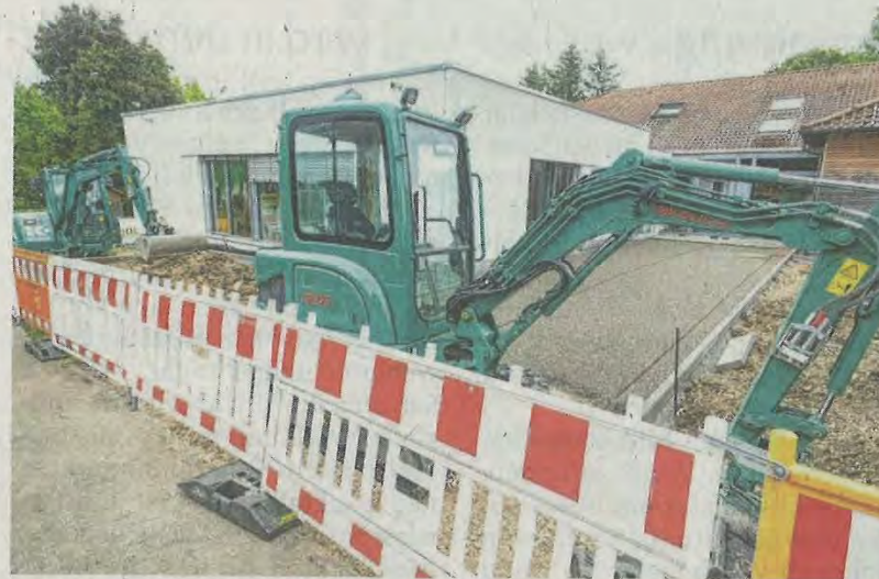
Außen noch eine Baustelle: Der Anbau beim Kinderhaus Dürnau/Gammelshausen wird bereits genutzt.
