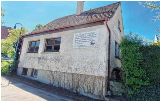
Soll innen wie außen ertüchtigt werden: Das Gammelshäuser Backhaus im historischen Ortskern
