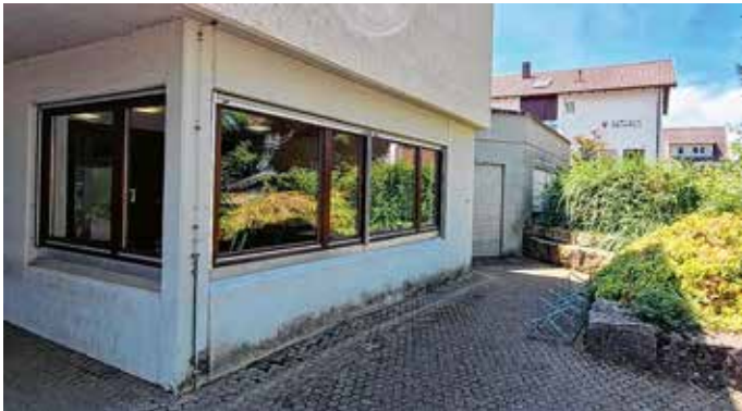
Hier soll ein Treffpunkt für Jugendliche aus Gammelshausen eingerichtet werden: der ehemalige katholische Raum im Untergeschoss des Gemeindehauses in Richtung Rosenstraße
