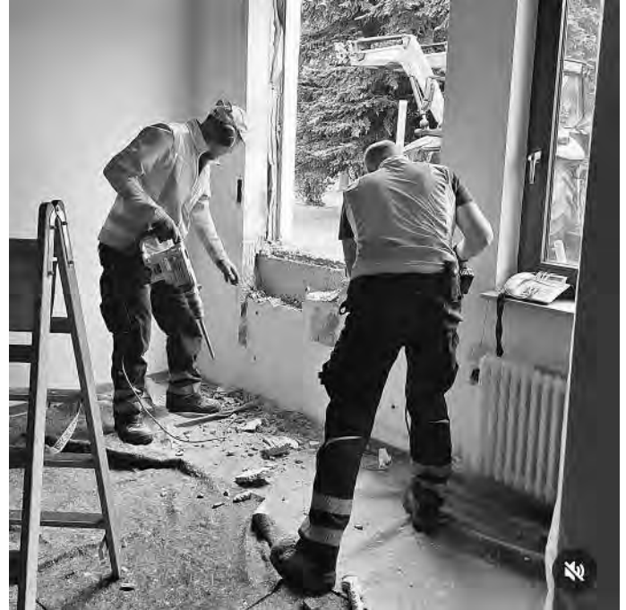
Bauhof in Aktion: Vorbereitungen für einen 2. Rathauszugang
