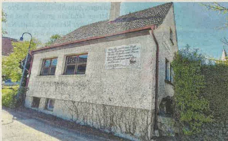
Das Gammelshäuser Backhaus soll saniert werden.
