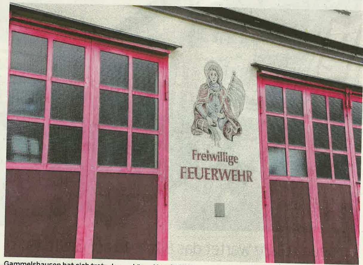
Gammelshausen hat sich trotz der prekären Haushaltslage einiges vorgenommen. Für die Erweiterung des Feuerwehrmagazins wurde ein Schlüssel-Grundstück erworben.
