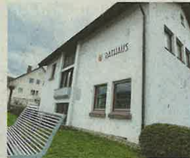
Am Fenster unten rechts kommt der barrierefreie Eingang.
