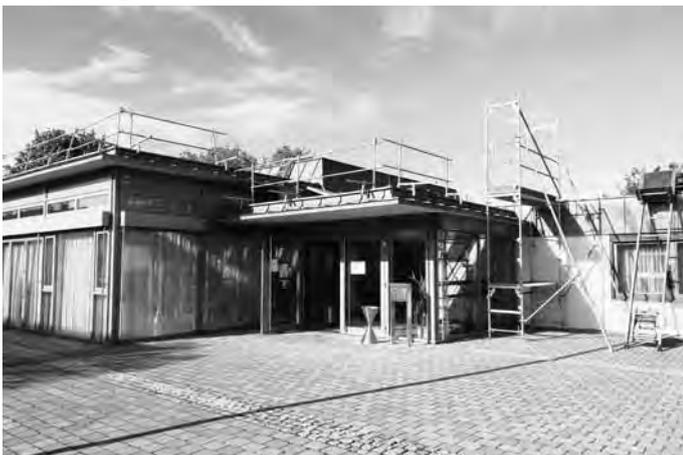
Auf dem Gemeindehaus schreiten seit dem 18. Mai 2021 die Arbeiten für die Errichtung einer Photovoltaikanlage voran. Hierfür kann die veranstaltungsfreie Zeit im Gemeindehaus gut genutzt werden. Neben der Anlage mit einer Leistung von knapp 30 kWp wird die in die Jahre gekommene Elektro-Hauptverteilung des Gemeindehauses erneuert. Die Maßnahmen werden mit knapp 70.000 Euro zu Buche schlagen.
