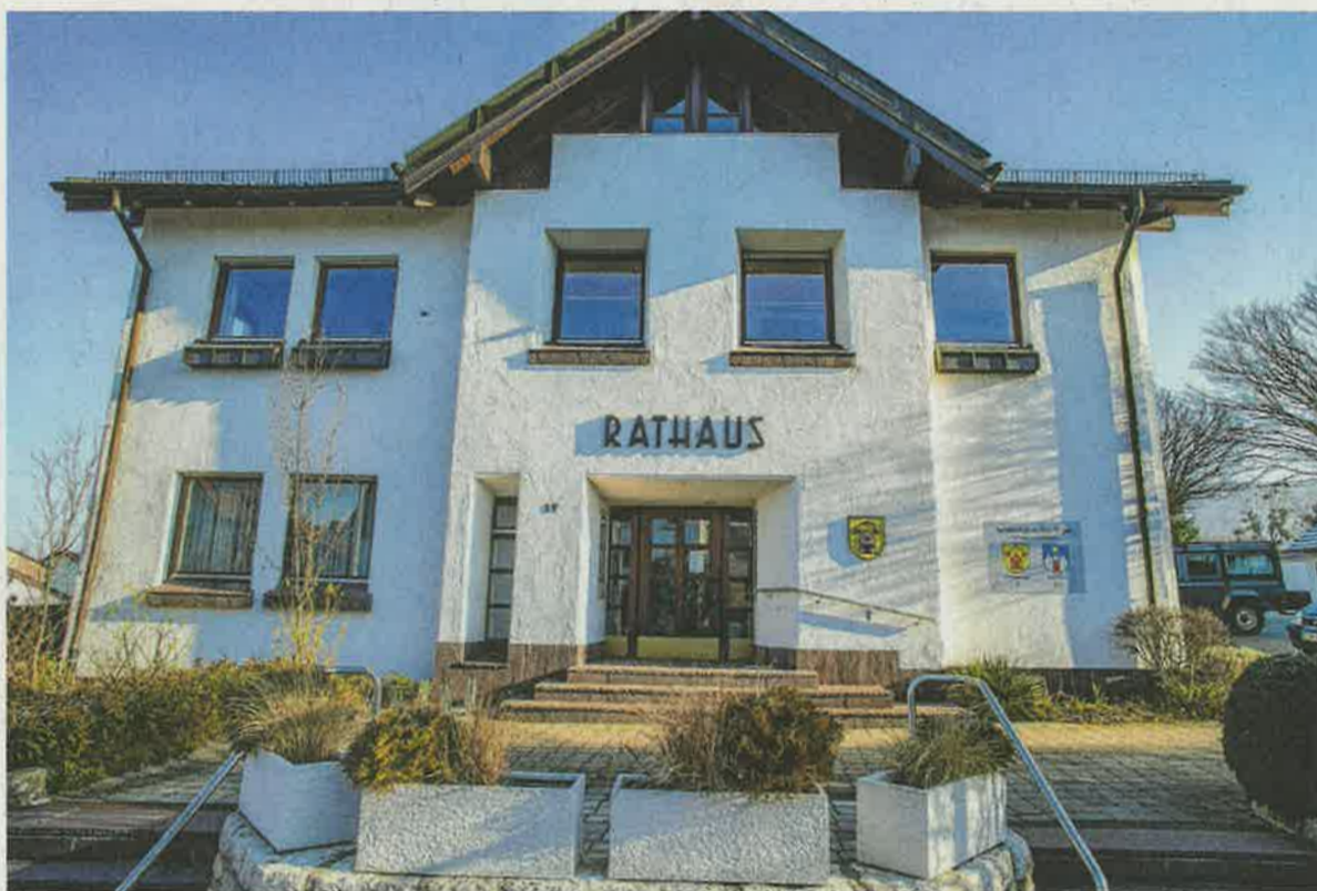
Sieht noch proper aus. Aber im Inneren des Gammelshäuser Rathauses muss einiges auf Stand gebracht werden. Barrierefrei ist es auch nicht. Foto: Staufenpress
